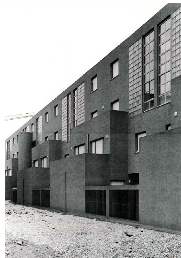
Ballatoio, canna di ventilazione e fronte esterno
