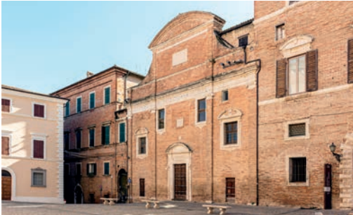
Immagine dello stato attuale della ex chiesa di S. Agostino in Piazza Colocci a Jesi
